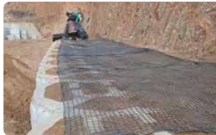
5. 연속작업 - 그리드 포설 및 다음 단 쌓기 (60cm 마다 옹벽높이의 70%이상의 그리드 포설)
