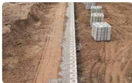
2. 첫단쌓기 및 유공관 설치
