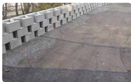
5. 연속작업 - 그리드 포설 및 다음단 쌓기 (60cm 마다 웅벽높이의 70%이상의 그리드 포설)
