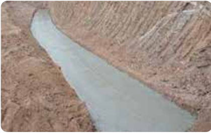
1. 터파기 및 기초작업 (기초 콘크리트 타설 / 기초잡석 40mm 이하)
