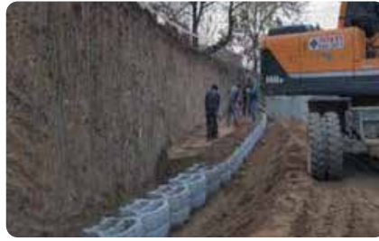
2. 첫단쌓기 및 유공관 설치
