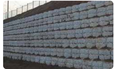
6. 마감블럭 설치 및 완공
